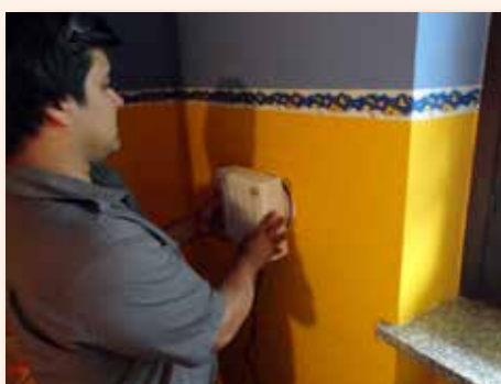
posizionamento gruppo motore
