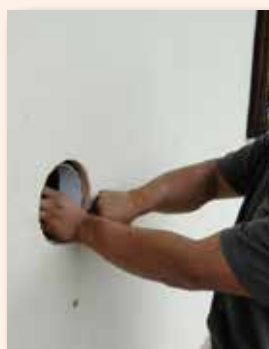
inserimento scambiatore calore
