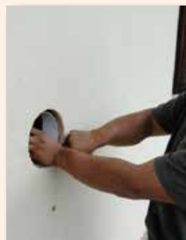
inserimento scambiatore calore
