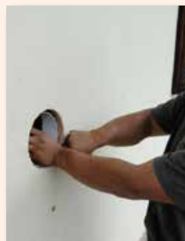
inserimento scambiatore calore
